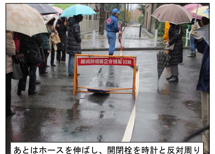
次に消火栓開閉器を開閉栓（四角い突起）に差し込み、時計と反対回りに回すと水が出て来ました
