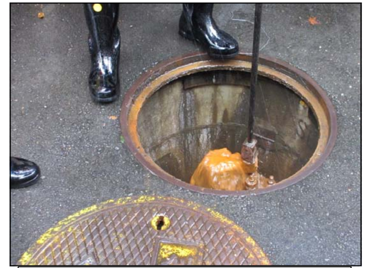
次に消火栓開閉器を開閉栓（四角い突起）に差し込み、時計と反対回りに回すと水が出て来ました
