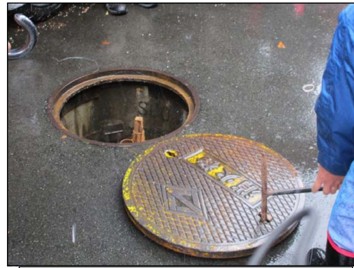
まず消火栓開閉器をマンホールの蓋の穴に差し込み、手前に引きます。力とコツが必要です。
