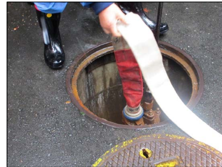
開閉栓の隣にある吐出口にホースを「カチッ」と差込みます。差込みの確認は万全を期します。
