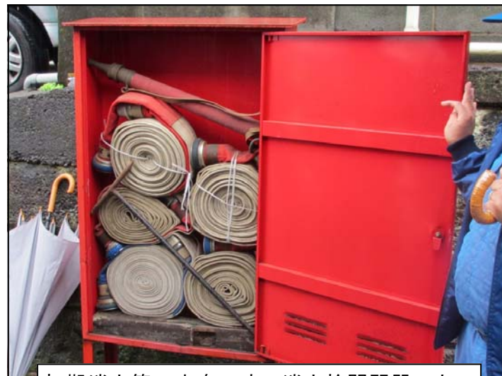
初期消火箱の中身です。消火栓開閉器、ホース、筒先の3点です。ホースは1本20mです
